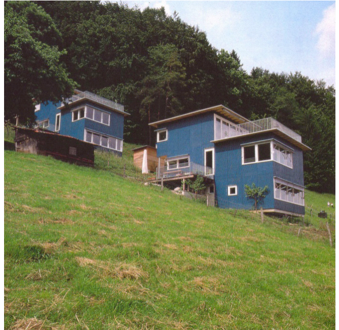
Die kleinmassstäblich gestaffelten Bauten fügen sich mit geringen Terrainveränderungen in den Hang ein (Brugg, Projekt Architheke).
