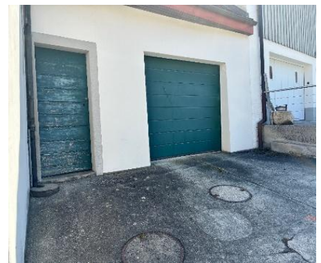
Garagentor rechts mit Türe links
